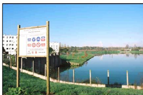
Bassin d'étalement extérieur
