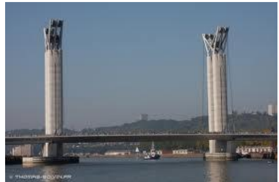
Pont Flaubert – 32 machines asynchrones 37kW
