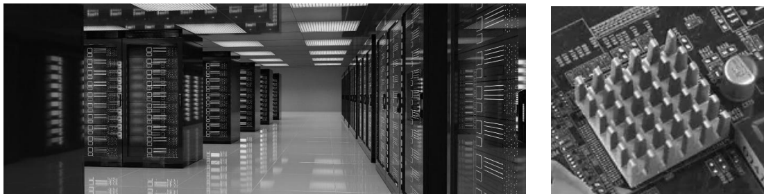
Figure 1 : Data center (à gauche) ; ailettes de refroidissement (à droite, dimensions typiques 10 mm x 10 mm x 1,0 mm)
