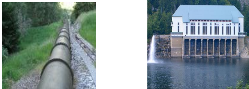
Figure 2 : À gauche : conduite métallique utilisée pour acheminer l'eau en mode « direct » ; à droite : vue depuis le lac Noir de l'arrivée d'eau acheminée en mode « direct »
