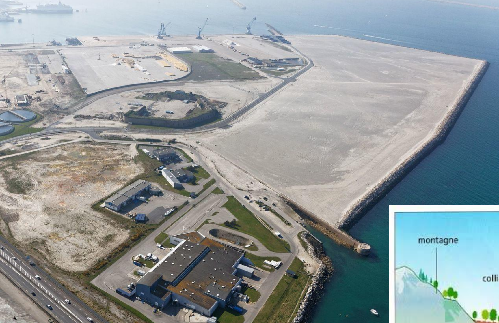
Terre-plein du Port de Cherbourg
