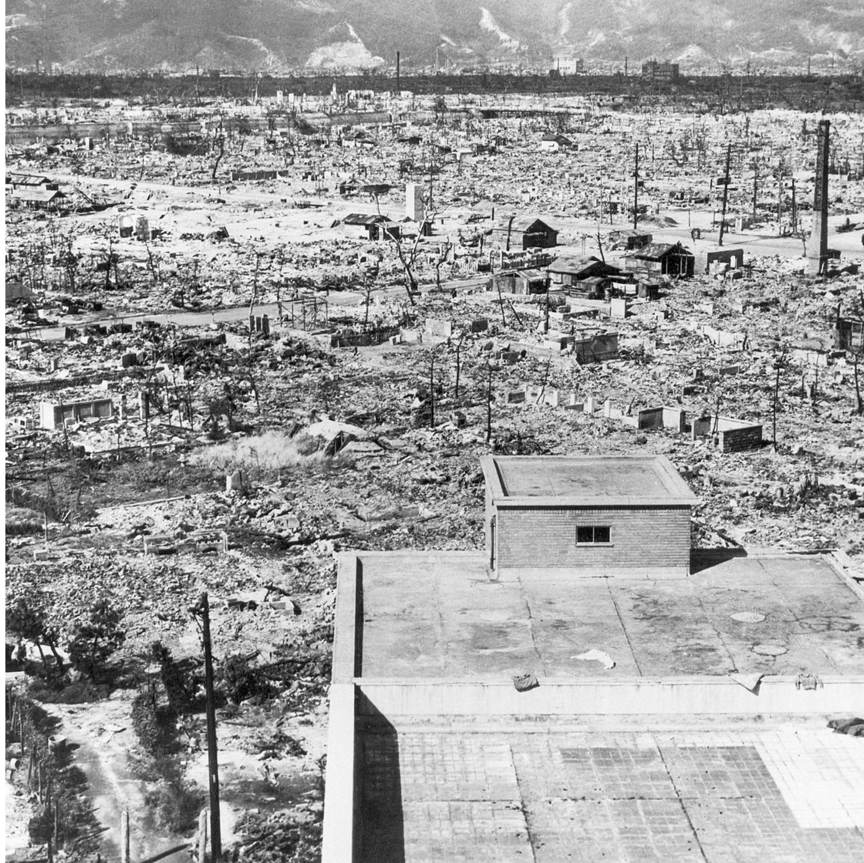
Dégâts dans le centre d'Hiroshima
