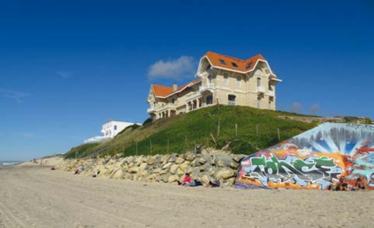
Côte landaise à Biscarosse, protection lourde par enrochement d'une villa ancienne construite dans la dune. Photo A. Miossec.
