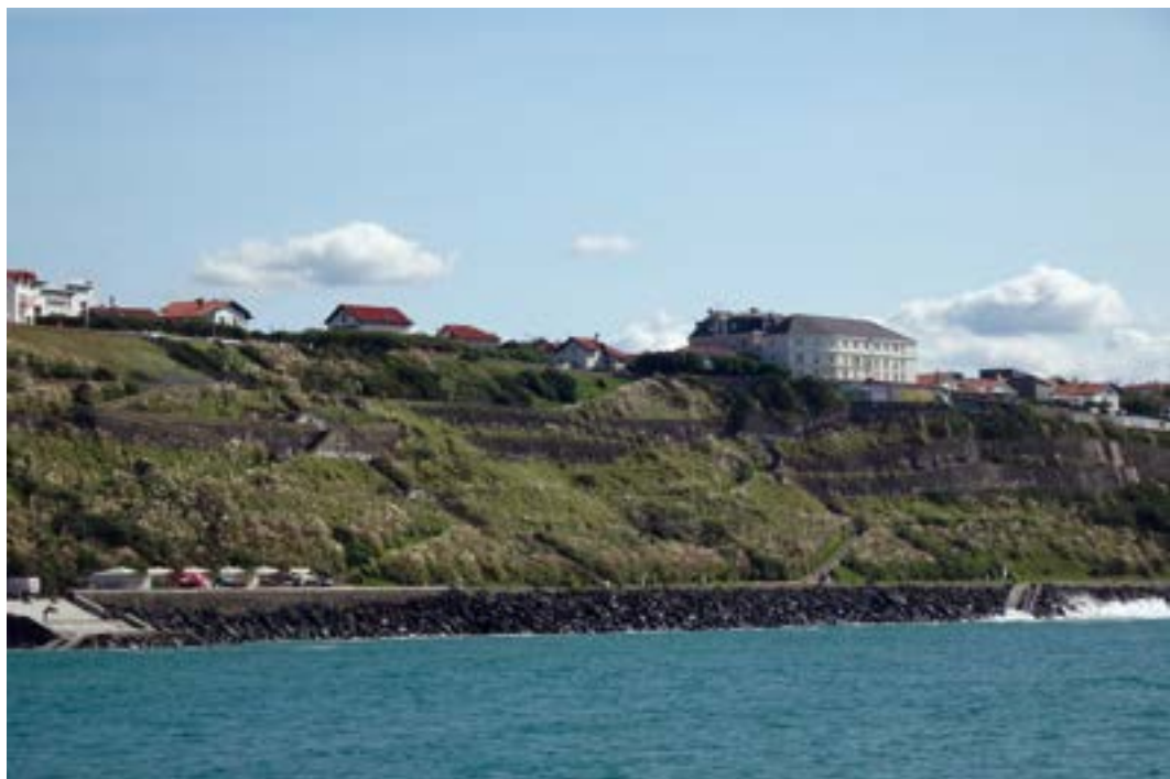
Côte des Basques à Biarritz, falaise stabilisée par un gros enrochement en ophite à la base, des pans de mur, du béton poreux sur lequel pousse la végétation. Photo A. Miossec.
