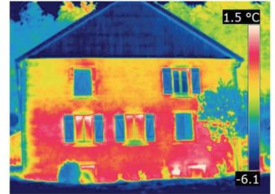
On s'intéresse à un mur de béton de surface  $S = 25 \text{m}^2$  et d'épaisseur  $e = 15 \text{cm}$ . Le béton a pour conductivité thermique  $\lambda = 0,92 \text{W} \cdot \text{m}^{-1} \cdot \text{K}^{-1}$ . Il règne à l'extérieur de l'habitation une température de  $4^\circ\text{C}$  et à l'intérieur une température de  $19^\circ\text{C}$ .
