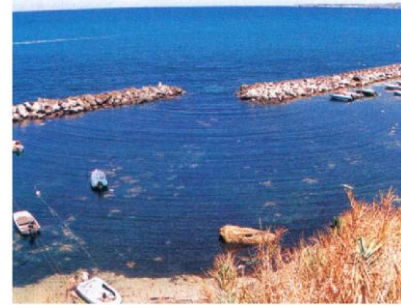
Fig.2 : Diffraction des ondes à la surface de l'eau
