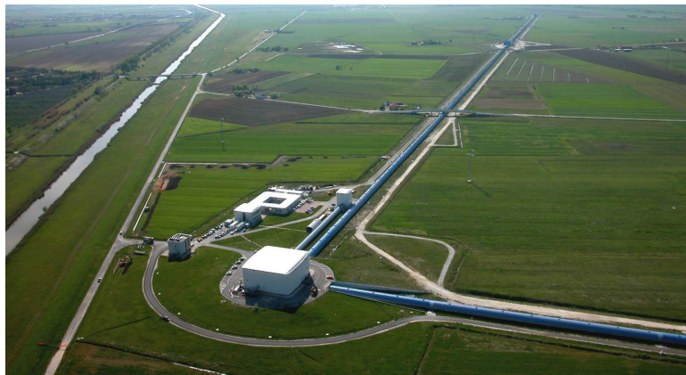
Figure 4.5 – Photo aérienne de l'interféromètre Virgo à Santo Stefano en Italie (le bras ouest d'une longueur de 3 km est visible en entier) 1 .
