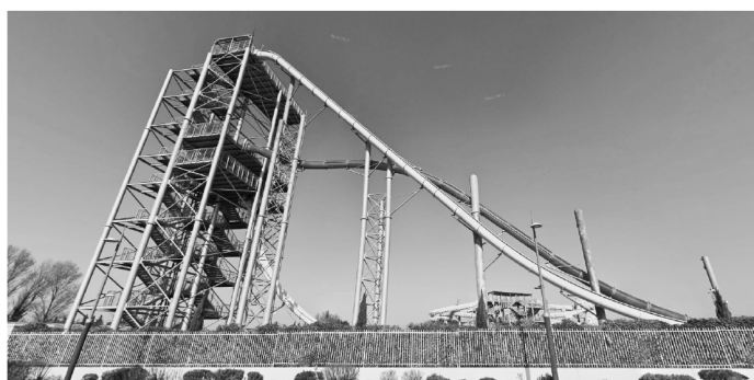
Figure 1: Gauche : photographie du toboggan "le géant" du parc de Wavelsland. Pour ce toboggan, qui est le plus haut de France h = 33\text{ m} et \alpha \approx 45^\circ . Droite : modélisation retenue pour l'étude du toboggan.
