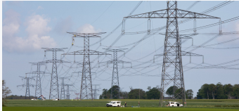
Ligne haute tension
