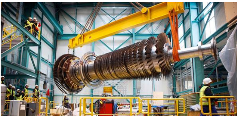
Turbine de centrale nucléaire
