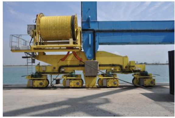
Photographie du pied de grue (le tambour supérieur permet l'enroulement du câble d'alimentation 20 000 V)
