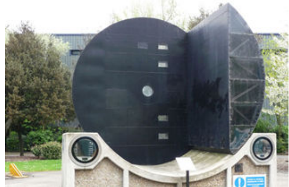
FIGURE 6.2 – Porte du barrage en phase de maintenance.
