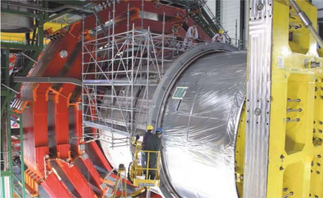
Montage du solénoïde supraconducteur du détecteur CMS au Cern. La culasse magnétique (en rouge), contenant l'enceinte à vide, est glissée autour du solénoïde entouré de ses écrans thermiques. En jaune, la plate-forme qui a permis le montage de la bobine et son basculement de la position verticale à la position horizontale.
