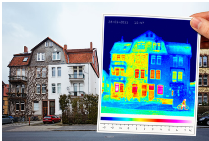
FIGURE 3 – Photo et image infrarouge d'un bâtiment partiellement isolé.
