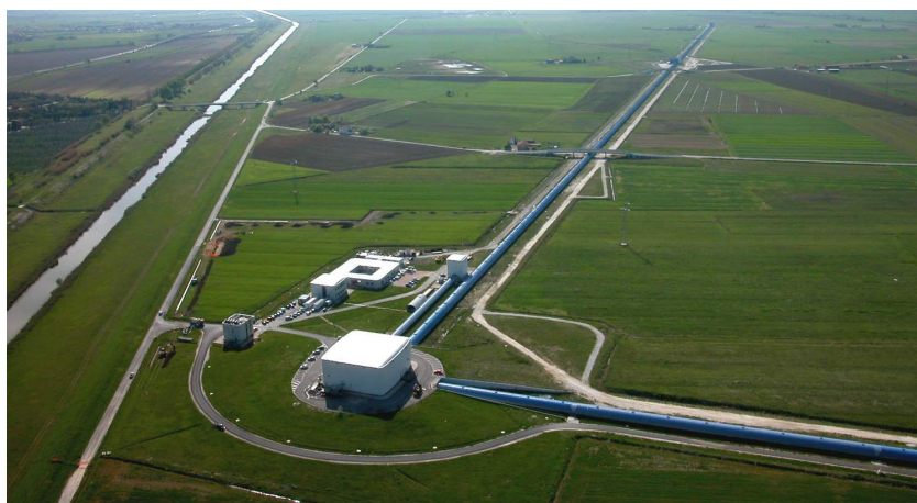
FIGURE 4 – Vue aérienne du site de l'expérience Virgo montrant le bâtiment central, le bâtiment du Mode-Cleaner, l'ensemble du bras ouest de 3 km de long et le début du bras nord (à droite)
