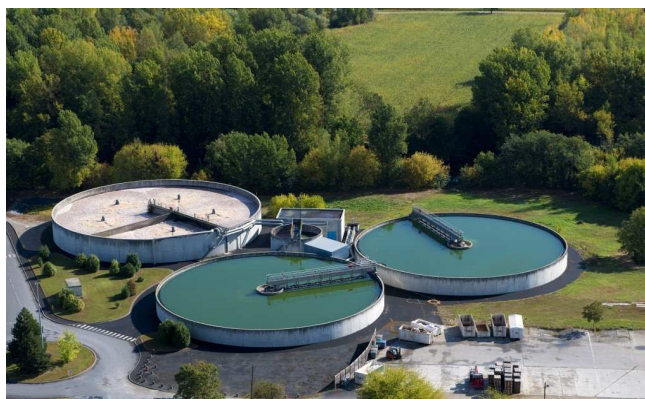
FIGURE 3 – usine de traitement des effluents.
