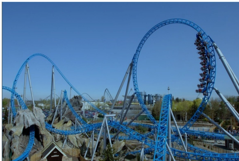
Figure 1 – Vue d'ensemble du Blue Fire
