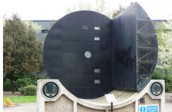
FIGURE 6.2 – Porte du barrage en phase de maintenance.
