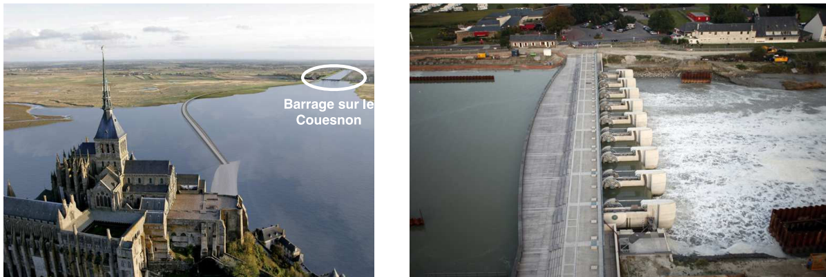
FIGURE 4.1 – Barrage du Couesnon.
