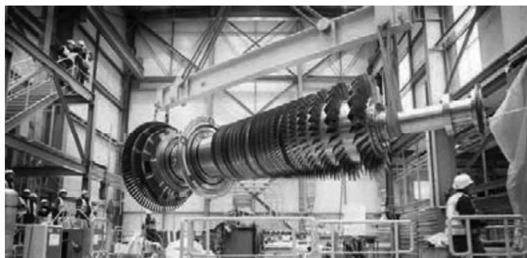
Turbine de centrale nucléaire
