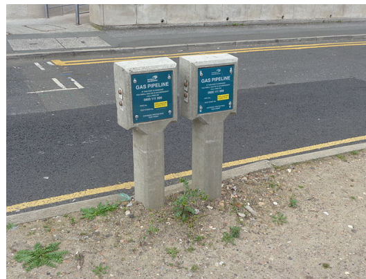
marqueurs de protection cathodique sur un gazoduc
