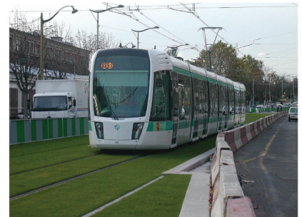
Tramway de la ligne T3, ici sur une section avec ligne aérienne de contact.
