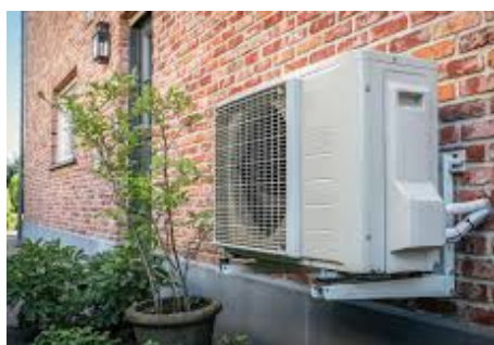
FIGURE 3 – Photographie d'une pompe à chaleur
