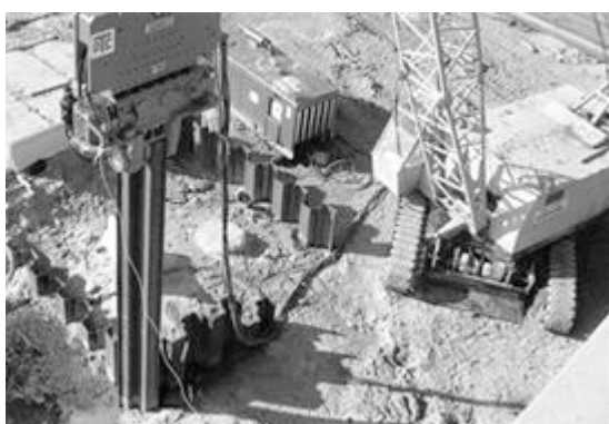
(a) Vibrofonçage de palplanches
