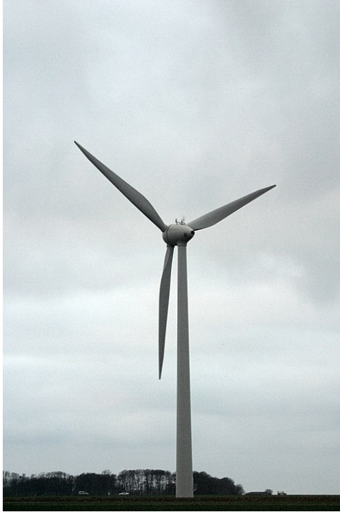
FIGURE 1 – Modèle Enercon E66. Hauteur : 100 m, puissance : 2 MW (parc d'Assigny).
